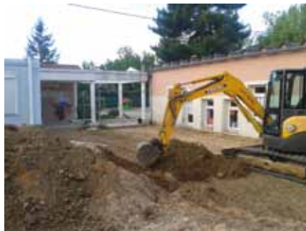
Construction de la 4 e classe maternelle
