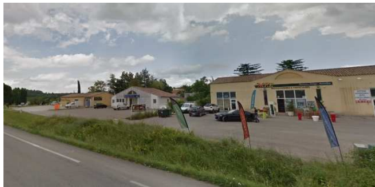
Linéaire commercial discontinu le long de la D3
